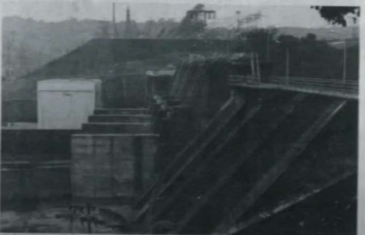
A barragem Edgard de Souza interrompe o rio Tietê, transformando-o num canal artificial.
