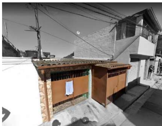
Telhado de fibrocimento 244 cm X 110 cm custa 50 reais.
