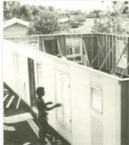
Figura 4: Exemplo de construção com painéis de madeira modulados.
