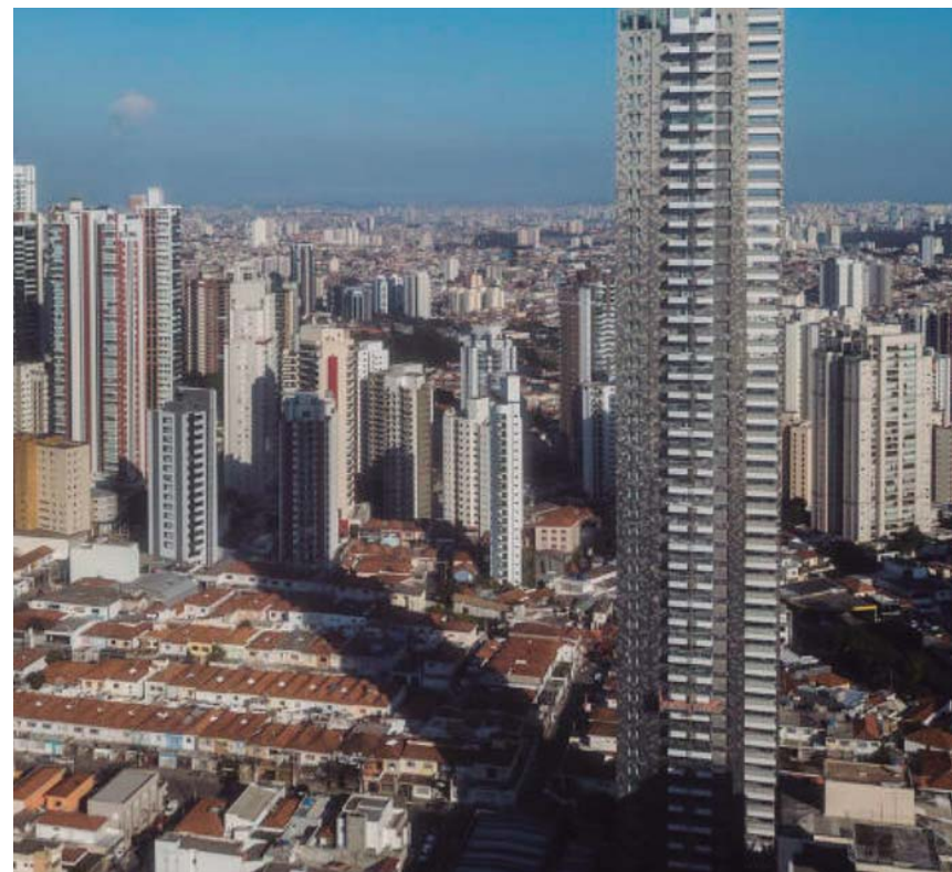
Edifício Figueira Altos do Tatuapé, maior residencial da cidade, com 168 metros de altura, e as casas na vizinhança -Eduardo Knapp In: https://www1.folha.uol.com.br/mercado/2021/09/predios-enormes-levantam-debate-sobre-limites-da-cidade.shtml
