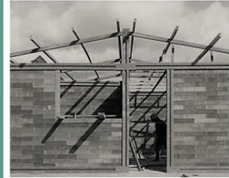
Escola Sokassou em construção, Costa do Marfim, Projecto de UNICEF
