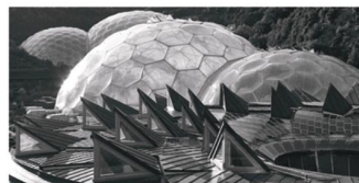
PROJETO EDEN cúpulas de plástico com estrutura hexagonal Nicholas Grimshaw arq.
